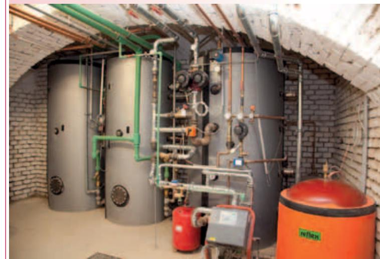
**Heizraum Wißgrillgasse mit Pufferspeichern für Pelletskessel und thermische Solaranlage** Foto: Ulreich Baurträger GmbH
